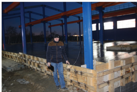
Прораб Владимир Доняев после окончания работ по заливке перекрытия К-2 в 21ч. 22 апреля
