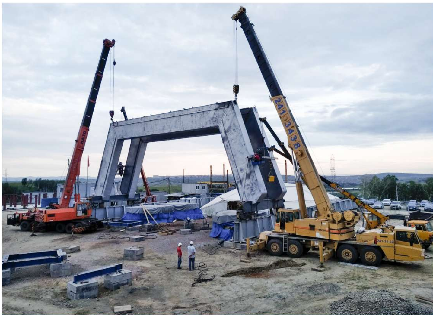
Монтаж крана грузоподъемностью 100 тонн
