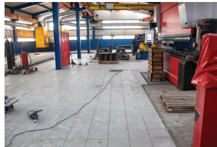
Укладка кафеля в корпусе К-2
