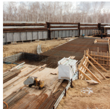
Подготовка ко 2 этапу заливки подовой печи
