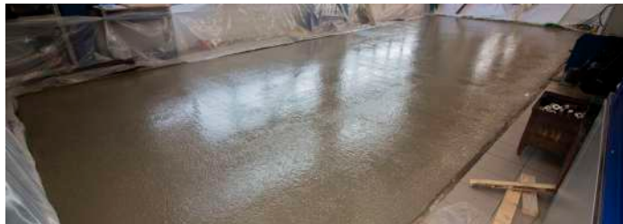
Площадка для временного размещения токарных и фрезерных станков в корпусе К-1
