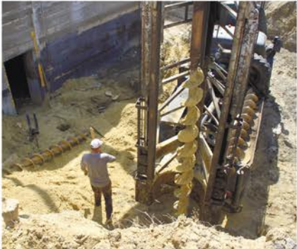
Бурение свай лестничного марша производственного корпуса К-2
