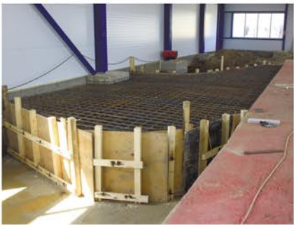
Армирование фундамента шлифовального станка Heckert SZ 1.6
