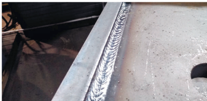
Сварочный шов на опоре колесной пары
