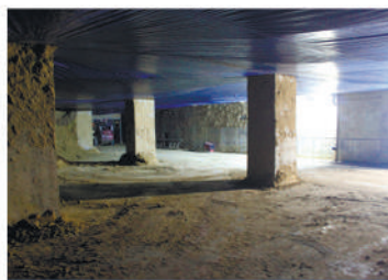
Цокольный этаж КПП
