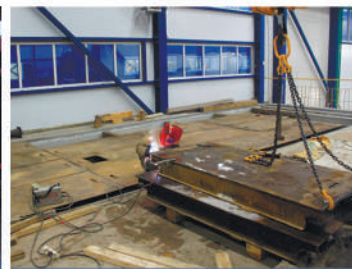
Монтаж временного перекрытия
