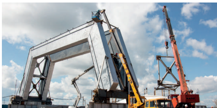
Установка крана грузоподъемностью 100 тонн
