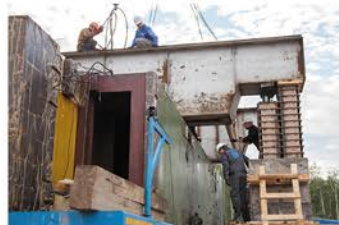
Прикрепление детали стропами к траверсе
