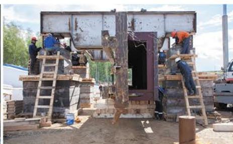
Завершение процесса бескрановой разгрузки - деталь опустилась на опоры из бруса
