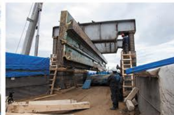
Груз закреплен, трал выезжает из-под детали
