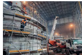
Резервуары для хранения серной кислоты. В течение года будет производиться 2,4 млн тонн продукта
