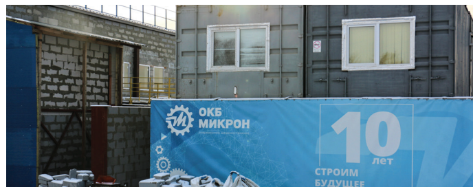
Контейнеры второго этажа АБК-2
