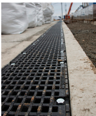
Строительство ливневки и тротуара
