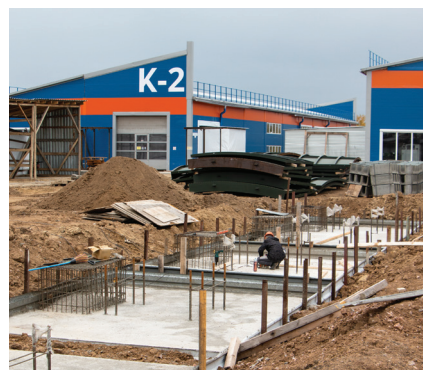
Заливка фундамента К-6
