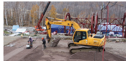
Строительство заводских проездов
