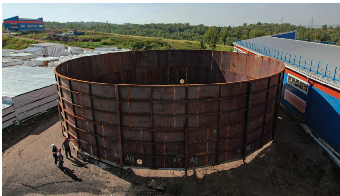
Процесс сборки резервуара
