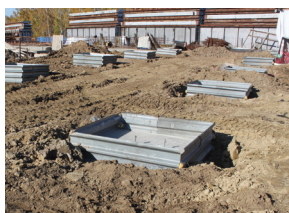
Ростверки для четвертого пролета К-6
