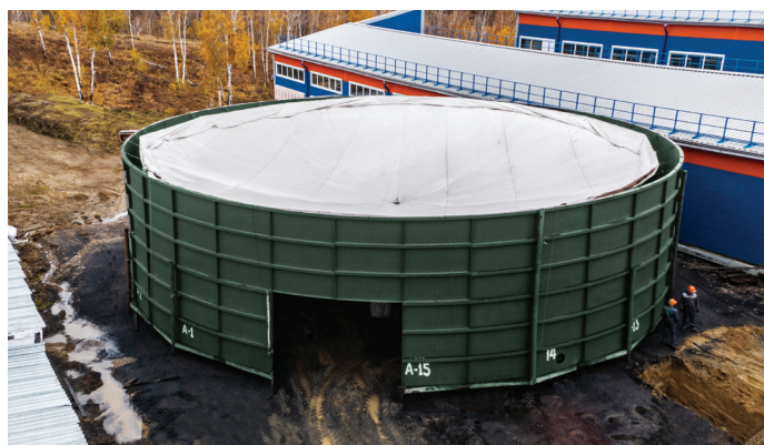
Резервуар для приема шахтной воды
