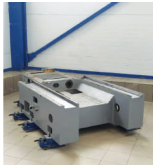
Монтаж станка с ЧПУ 6560 в корпусе К-7
