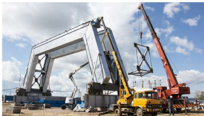
Монтаж 100-тонного крана
