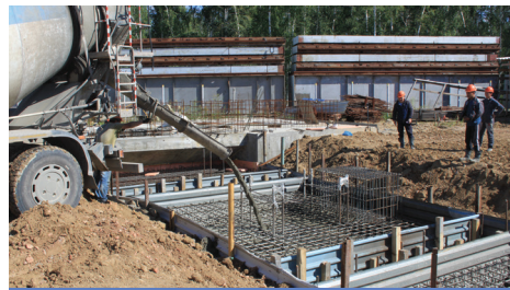
Заливка фундамента в корпусе К-6
