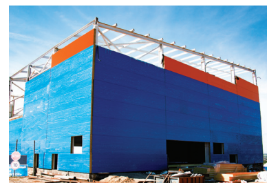
Монтаж панелей будущей столовой
