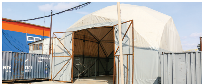
Временный крытый склад полуфабрикатов
