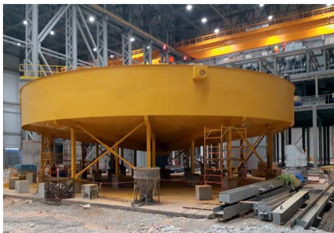
По ТЗ заказчика были спроектированы, изготовлены и смонтированы два сгустителя диаметром 22 м и весом 45 тонн каждый, а также два успокоительных чана объемом 60 м³
