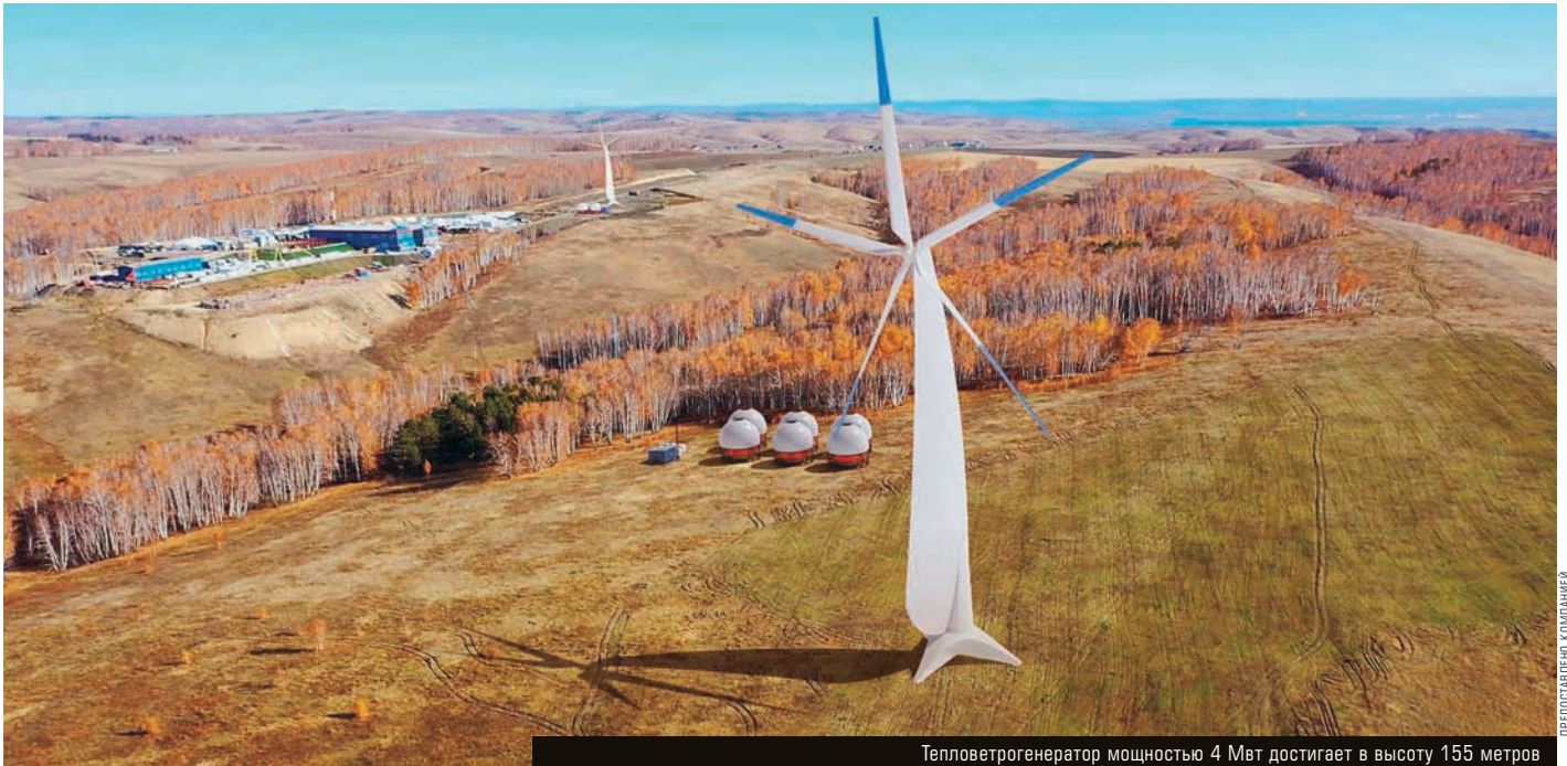
Тепловетрогенератор мощностью 4 Мвт достигает в высоту 155 метров
